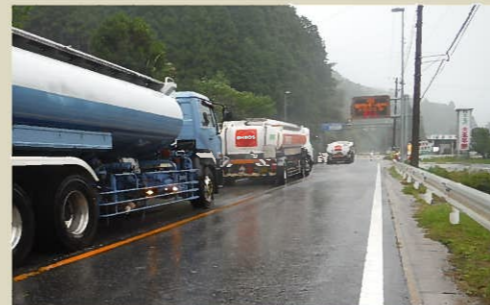
令和5年6月の豪雨では約10時間に及び通行止めが発生
