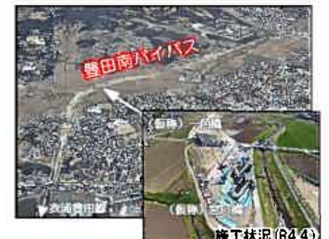
施工状況(R4.4)
