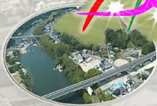
国道153号豊田北バイパス
