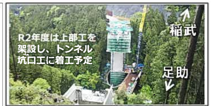
新郡界橋(仮称)現場写真(R2年5月18日撮影)
