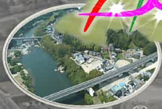
国道153号豊田北バイパス
