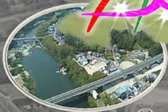
国道153号豊田北バイパス
