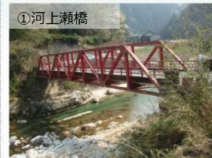
昭和34年開通(55歳)の橋梁
