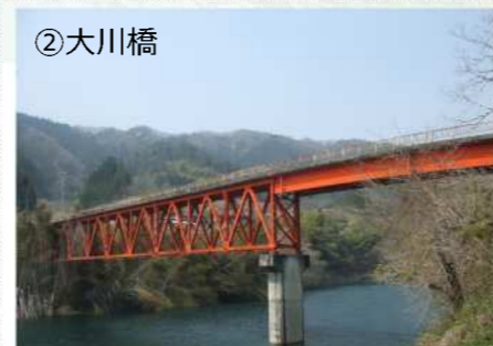
昭和43年開通(46歳)の橋梁
