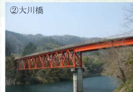
昭和43年開通(46歳)の橋梁
