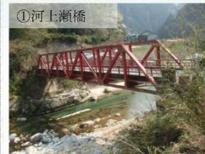
昭和34年開通(55歳)の橋梁
