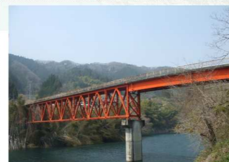
昭和 43 年開通 (46 歳) の橋梁
