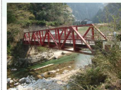
昭和34年開通 (55歳) の橋梁
