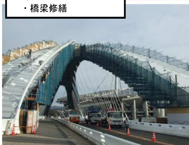
大規模橋梁の修繕 (豊田大橋)
