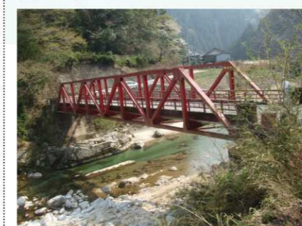
昭和34年開通 (55歳) の橋梁
