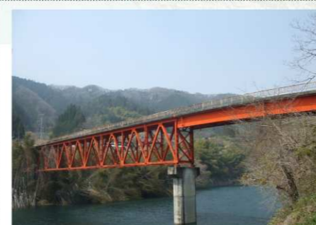
昭和43年開通 (46歳) の橋梁
