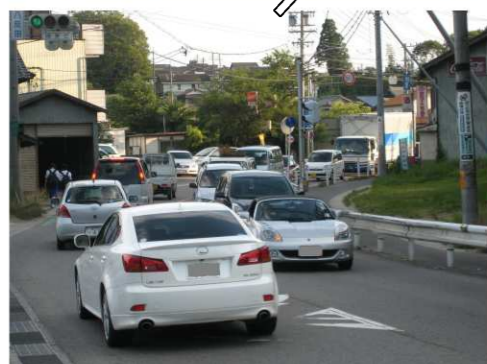
右折レーンの無い事故多発交差点 (国道419号：迫八反田交差点)
