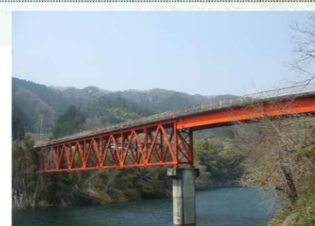
昭和43年開通 (46歳) の橋梁
