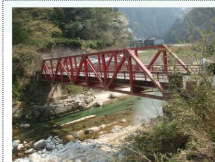
昭和34年開通 (55歳) の橋梁
