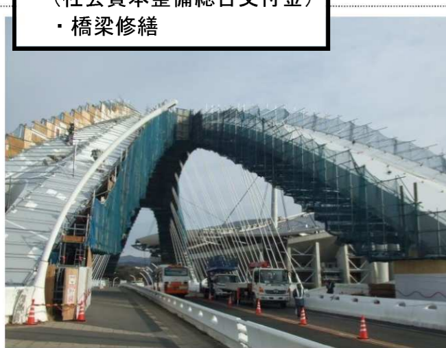
大規模橋梁の修繕 (豊田大橋)
