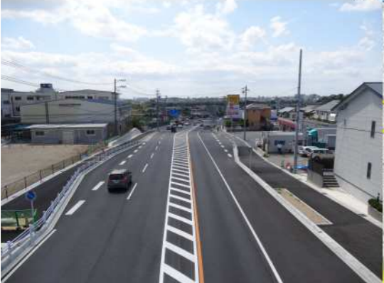
①野見山拡幅の様子 (写真A方向)
