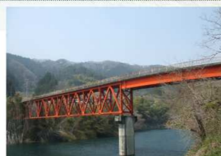
昭和43年開通 (46歳) の橋梁
