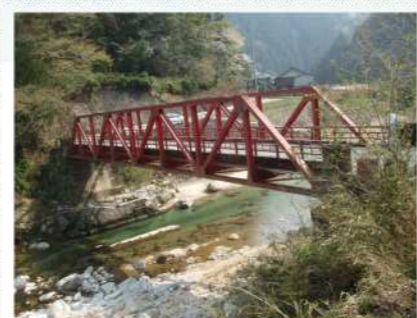
昭和34年開通 (55歳) の橋梁
