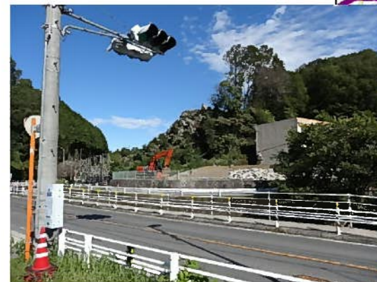
②九久平交差点改良の様子 (写真B方向)
