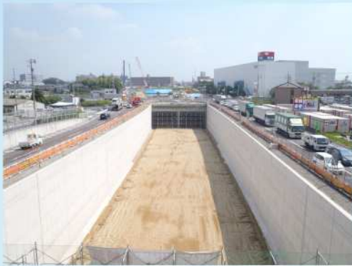
国道 155 号豊田南バイパス(美山町～東新町) (平成 25 年度供用予定)
